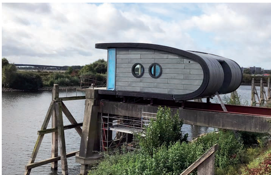
Dock Office met een buitenkant van gerecycleerd kunststof.
